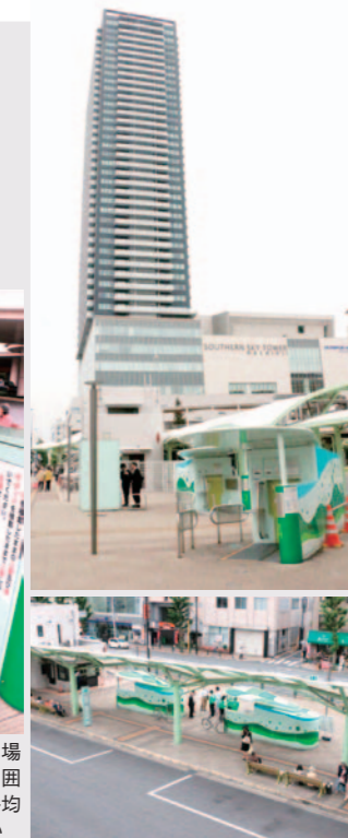
南口の地下タワー式自転車駐車場「エコサイクル」。ロータリーを囲むように6基設置されている。平均出庫時間は約13秒と非常に早い
